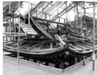
小屋組み改修時の様子
