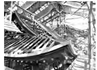
見学時の様子 軒付が付き垂木が施工されている
