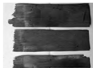
小屋裏に落ちていた旧柿板。明治期に棧瓦に改修されている
