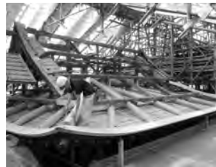
枯木5×4=20本と隅木が更新された
