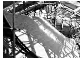
見学時には、土居葺きが完了していました
