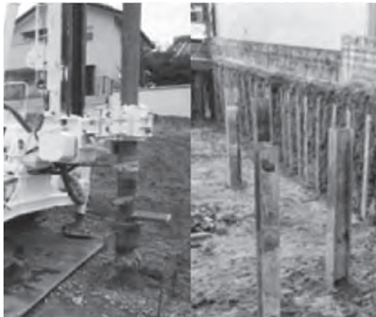
<土留工事> H鋼親杭土留工事・SMW工法等
