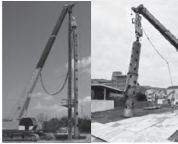
<杭抜き工事> 輪投げ工法・チャッキング工法
