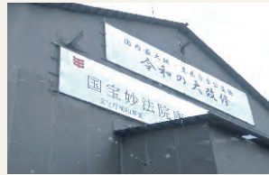
素屋根の外観
