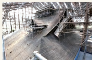
瓦を降して野地板が見える
