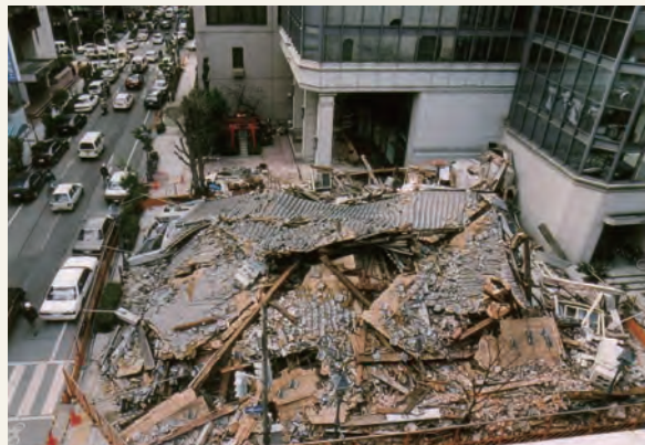
重要文化財旧神戸居留地15番館災害復旧
