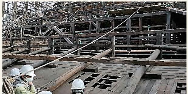
庫裡には天井が無いので小屋材も焼け壁も小屋裏まで
