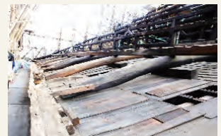
野地板を外した状況
