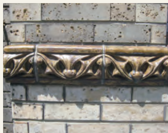
②「進々堂」の壁タイル
