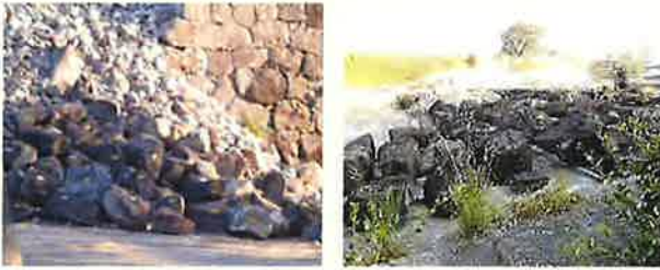
番付けされているも崩れたままの石垣石
