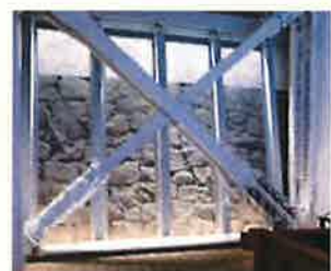
耐震補強（クロスダンパー）
