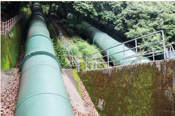
後背の仏徳山斜面に並ぶ5本の水圧鉄管
