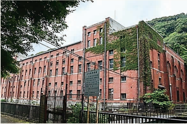
レンガ造の発電所本館
