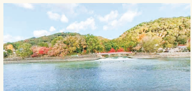
宇治発電所の現在 充分な築山と植栽で景観が改修されている
