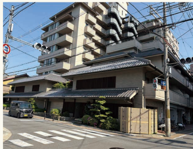
昭和61年頃建築のマンション
