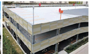
Case6 大阪府 立体駐車場
